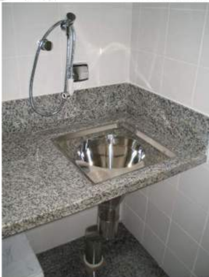
Foto 21 – Expurgo em aço inox de embutir.
