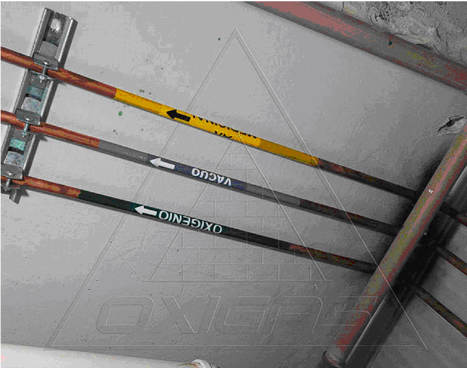
ILUSTRAÇÃO GENÉRICA DA IDENTIFICAÇÃO E FIXAÇÃO DAS TUBULAÇÕES DE GASES MEDICINAIS SEM ESCALA
